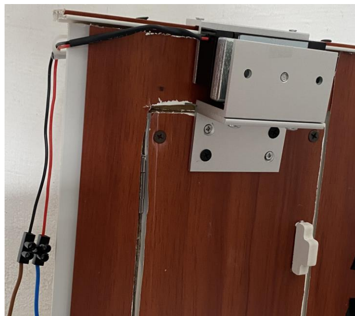
Gambar 3. Pemasangan Electric Magnetic Lock pada pintu laboratorium.
